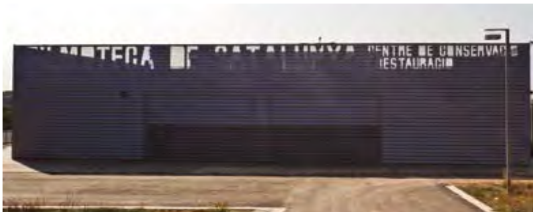
2CR, Centre de Conservació i Restauració de la Filmoteca de Catalunya, al Parc Audiovisual de Terrassa
