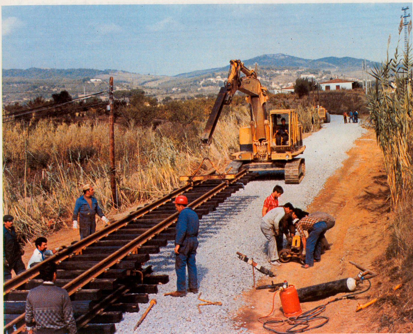
Obres de renovació de via. Tram Piera-Capellades. Línia de Catalans dels Ferrocarrils de la Generalitat. (Anoia)
