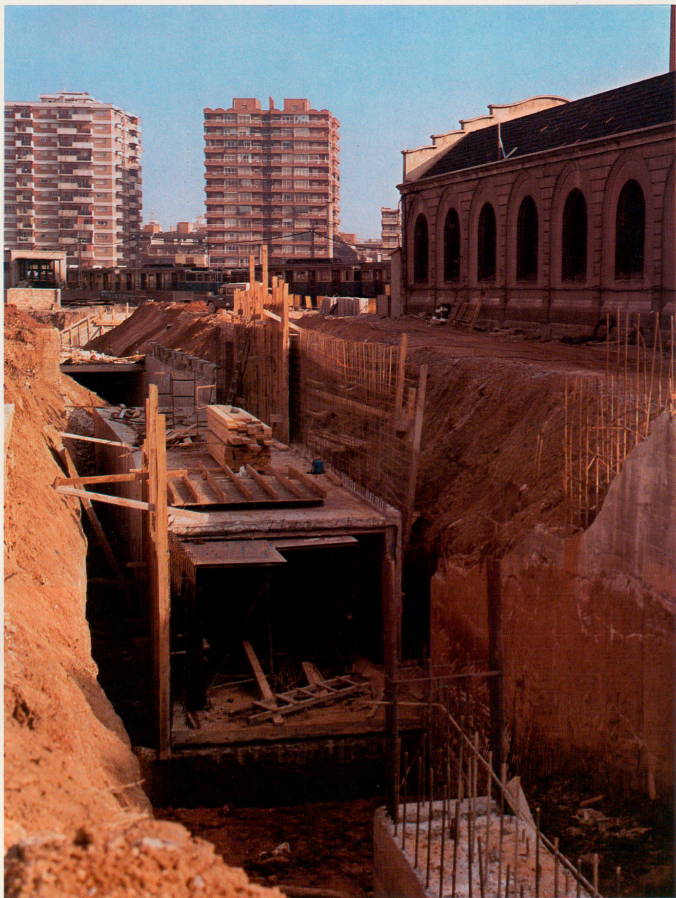
Construcció de la nova estació de Santa Eulàlia. Prolongació Santa Eulàlia a l'Hospitalet-Centre (Barcelonès). Ferrocarril Metropolità de Barcelona.
