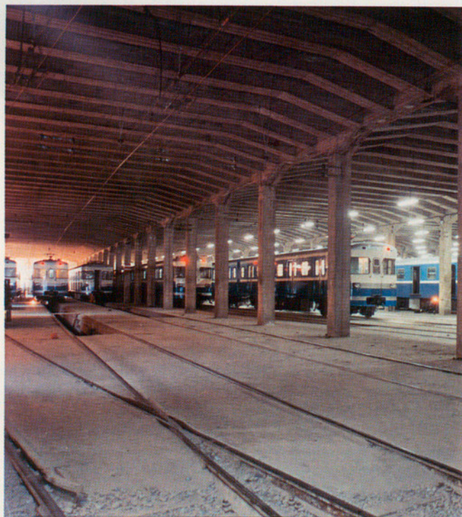
Interior de la nau de cotxeres Vilapiscina: Ferrocarril Metropolità de Barcelona.
