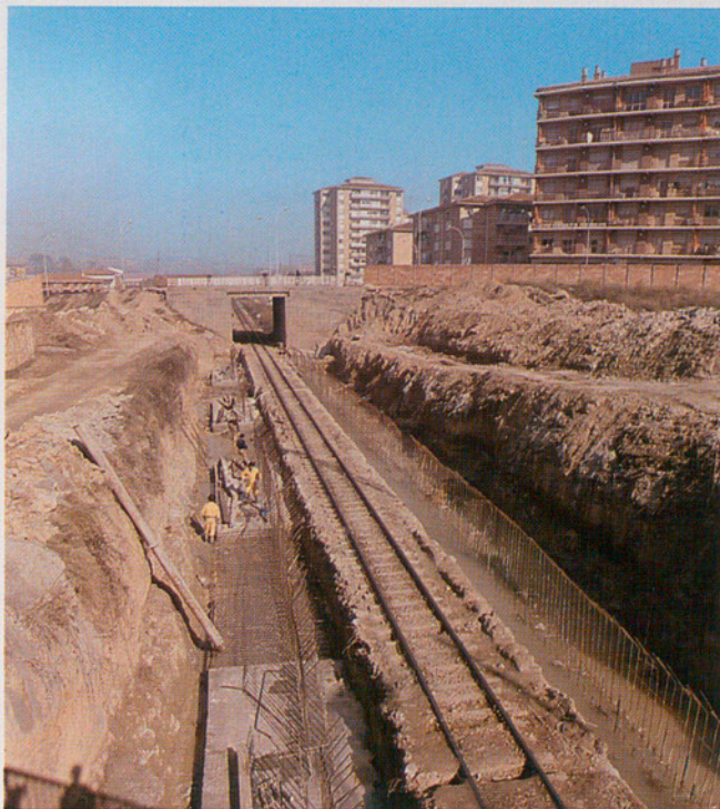
Cobertura dels F.G.C. entre el carrer de Sant Cristòfol i el túnel de Santa Clara a Manresa (Bages).
