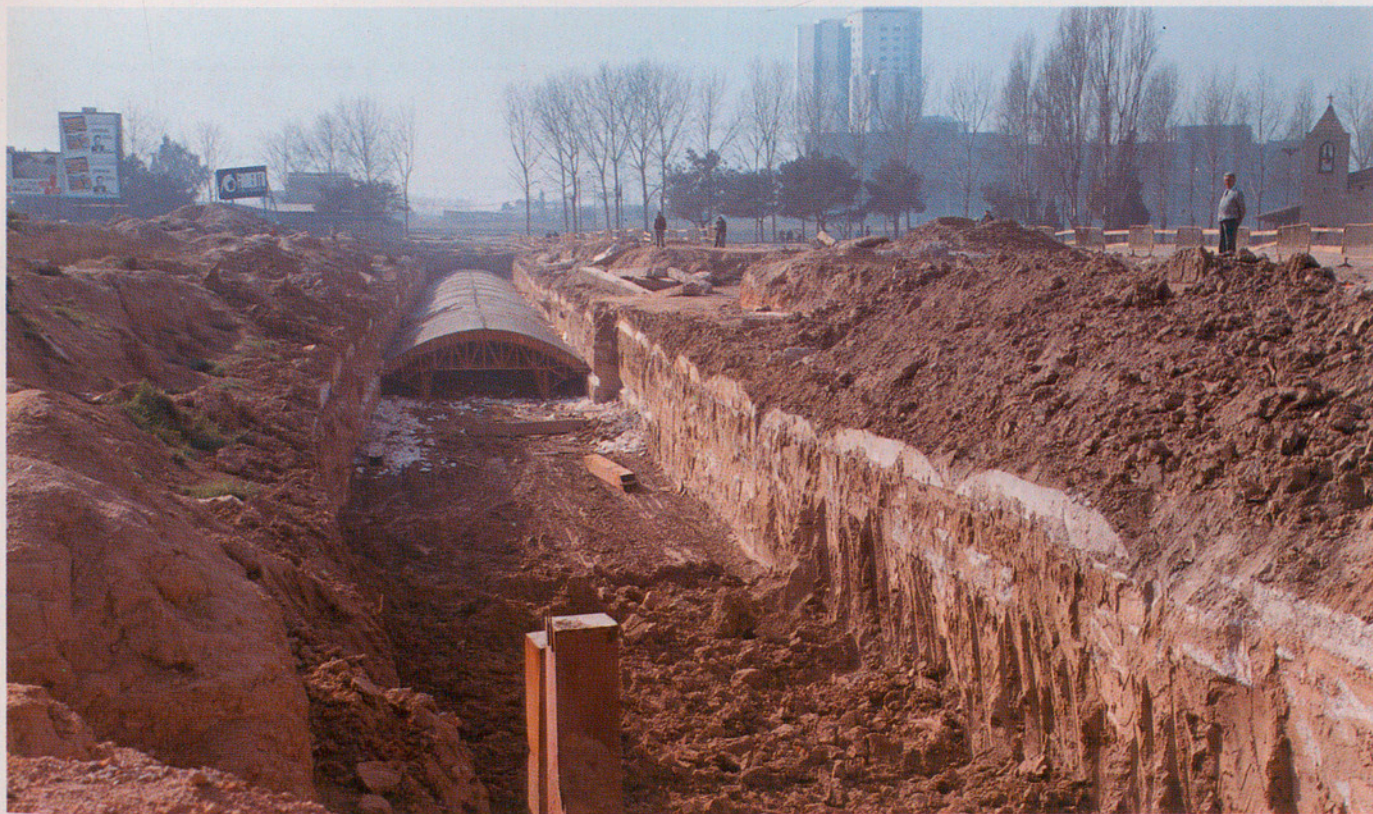
Túnel de la línia I del F.M.B., tram Ciutat Sanitària-Just Oliveres (Barcelonès).
