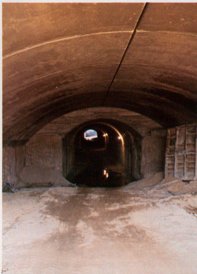
Estació Trinitat Vella, línia I del F.M.B. (Barcelonès).
