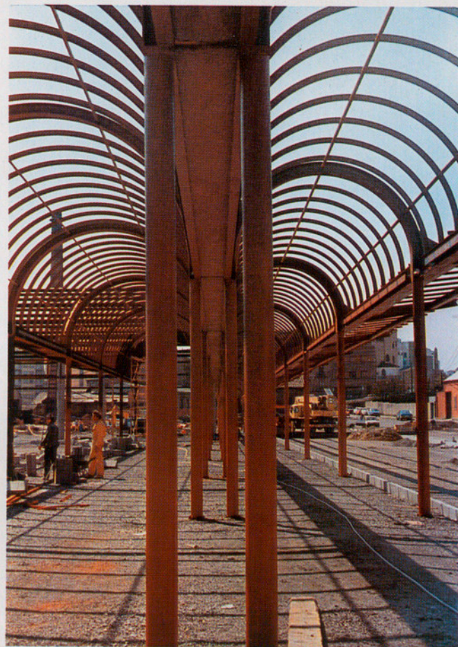
Estructura metàl·lica de l'Estació d'Autobusos de Manresa (Bages).
