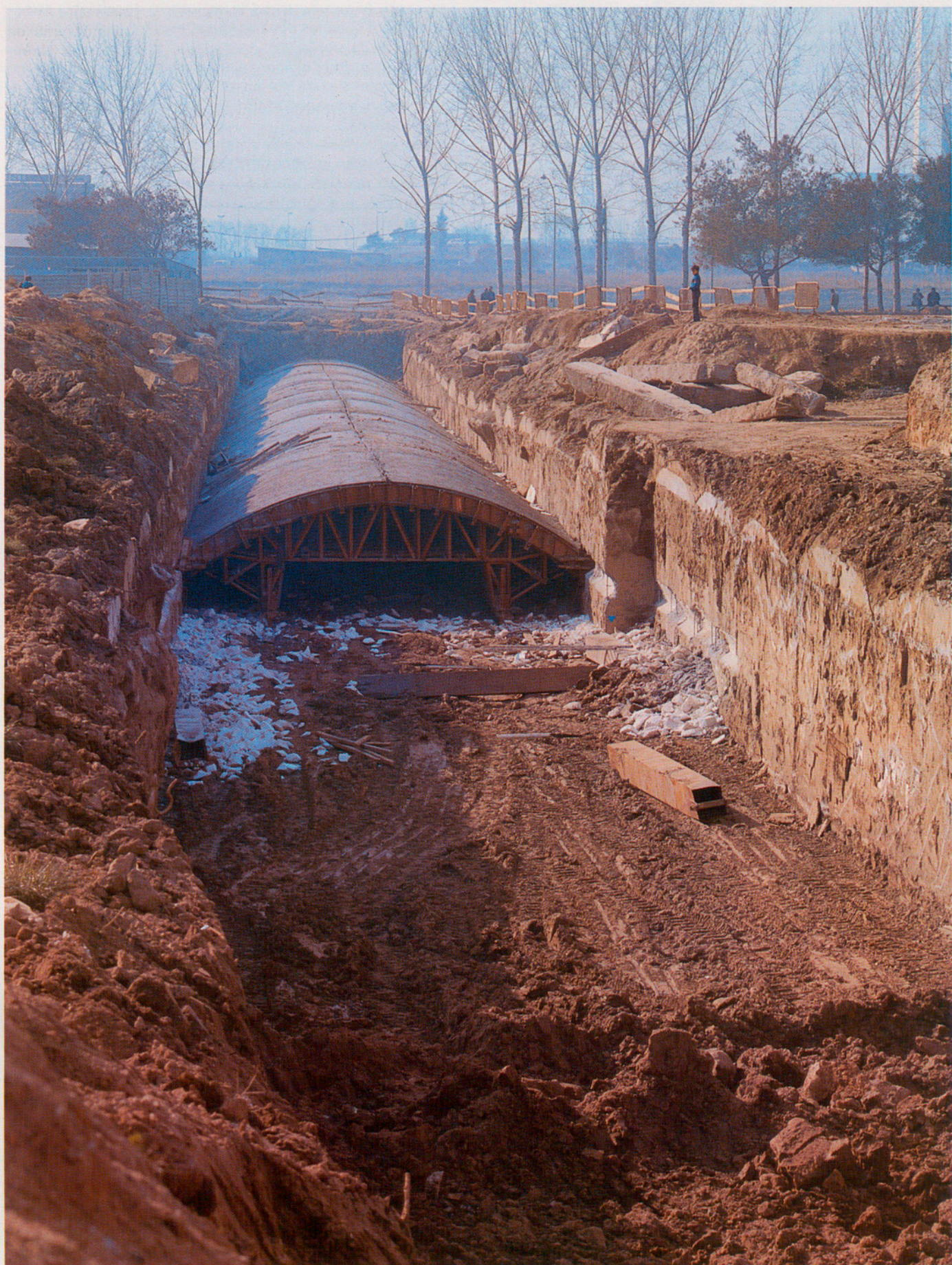
Túnel de la línia I del F.M.B., tram Ciutat Sanitària-Just Oliveres (Barcelonès).
