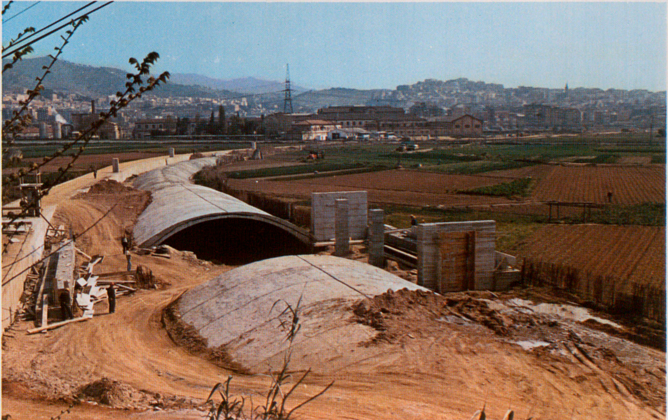
Estació Trinitat Vella, línia I del F.M.B. (Barcelonès).
