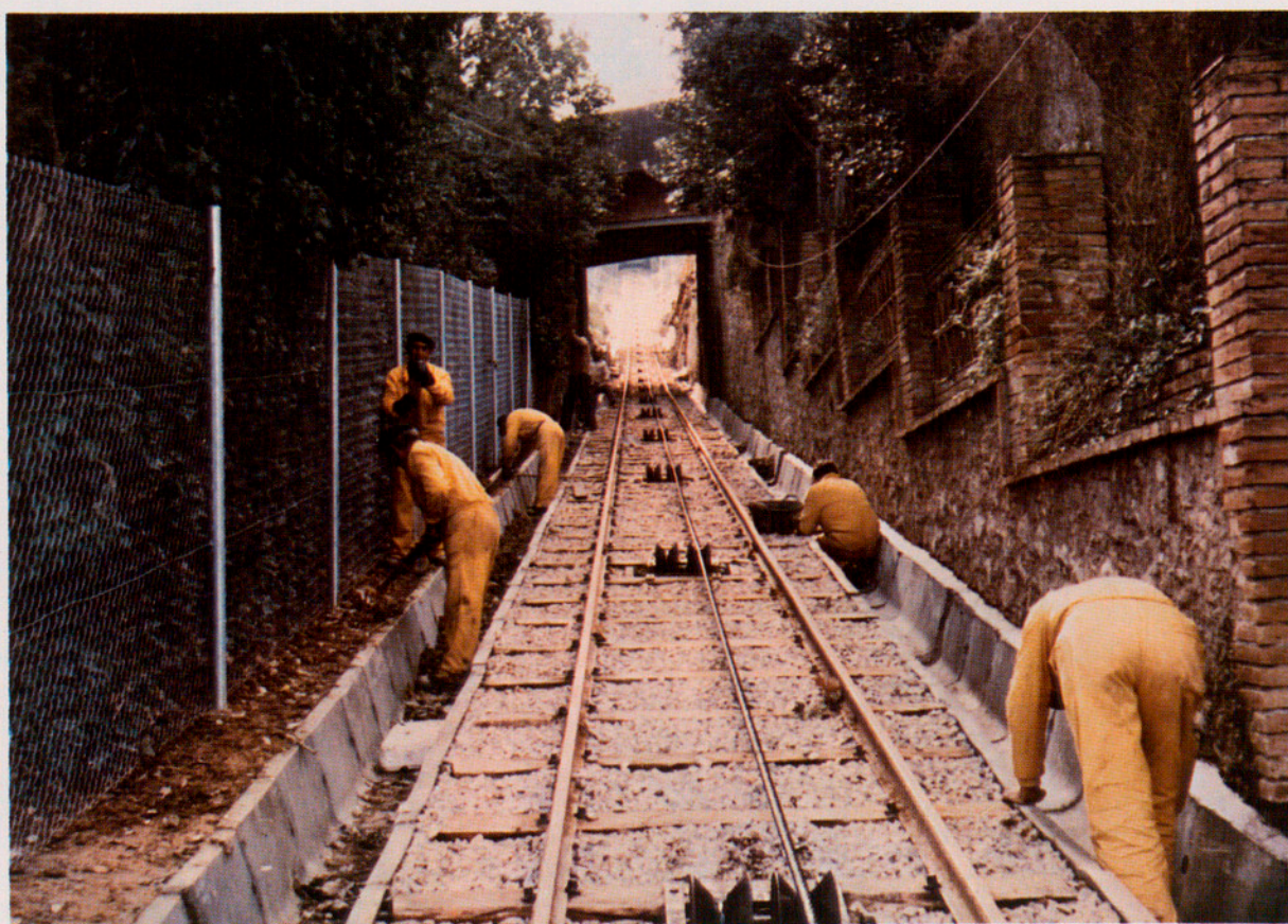
Funicular de Gelida, renovació de via (Alt Penedès).
