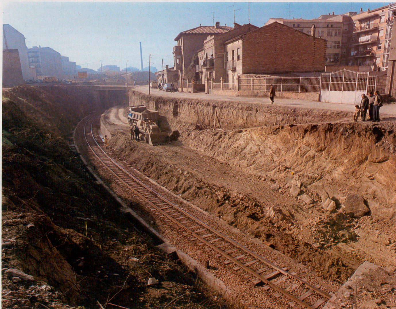
Cobertura dels F.G.C. entre el carrer de Sant Cristòfol i el túnel de Santa Clara a Manresa (Bages).
