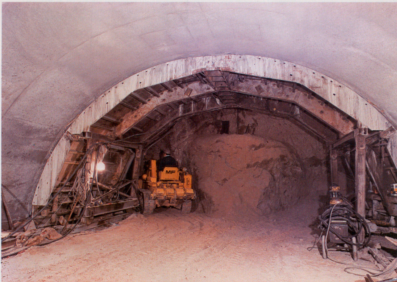
Execució túnel en galeria, línia I del F.M.B., tram Torres i Bages-Sta. Coloma de Gramenet (Barcelonès).
