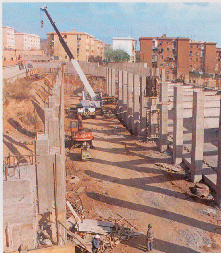
Tallers al costat de l'estació de Roquetes de la línia IV del F.M.B. (Barcelonès).
