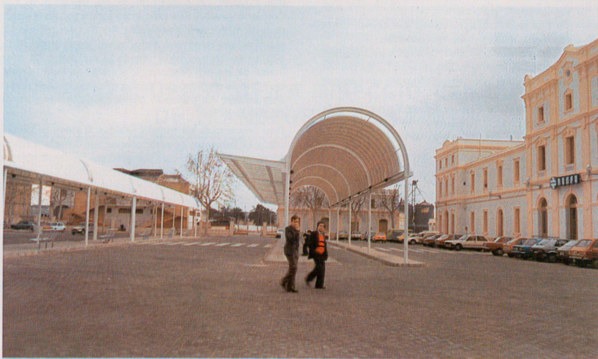
Vista de l'Estació d'Autobusos de Vilanova i la Geltrú (Garraf).
