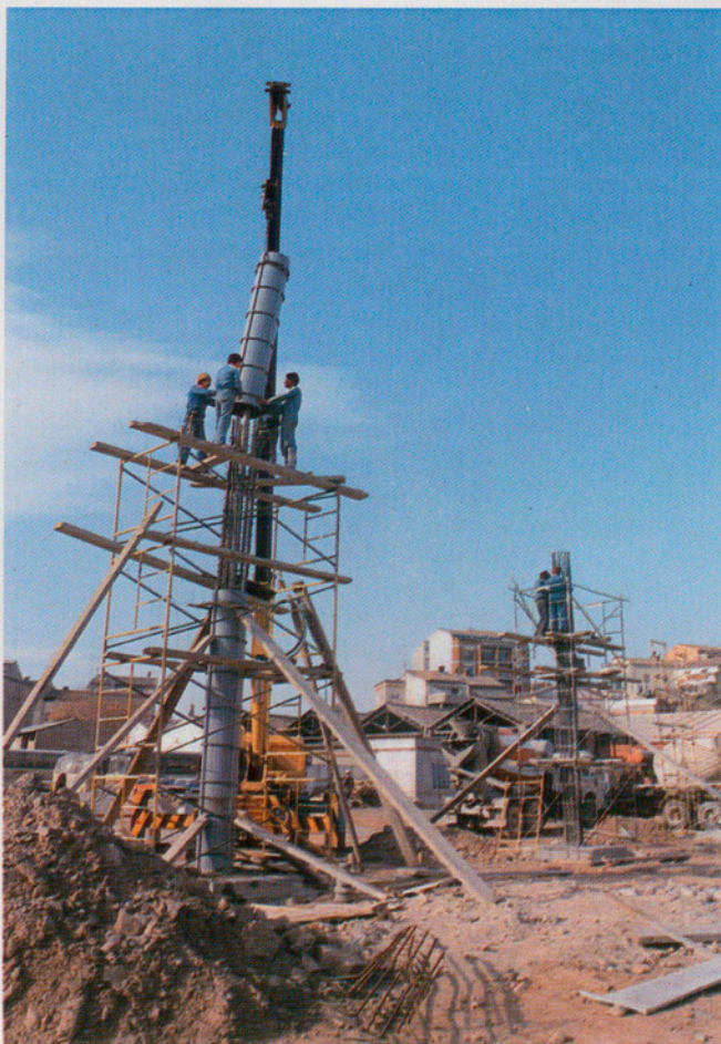
Construcció dels pilars de l'Estació d'Autobusos de Manresa (Bages).
