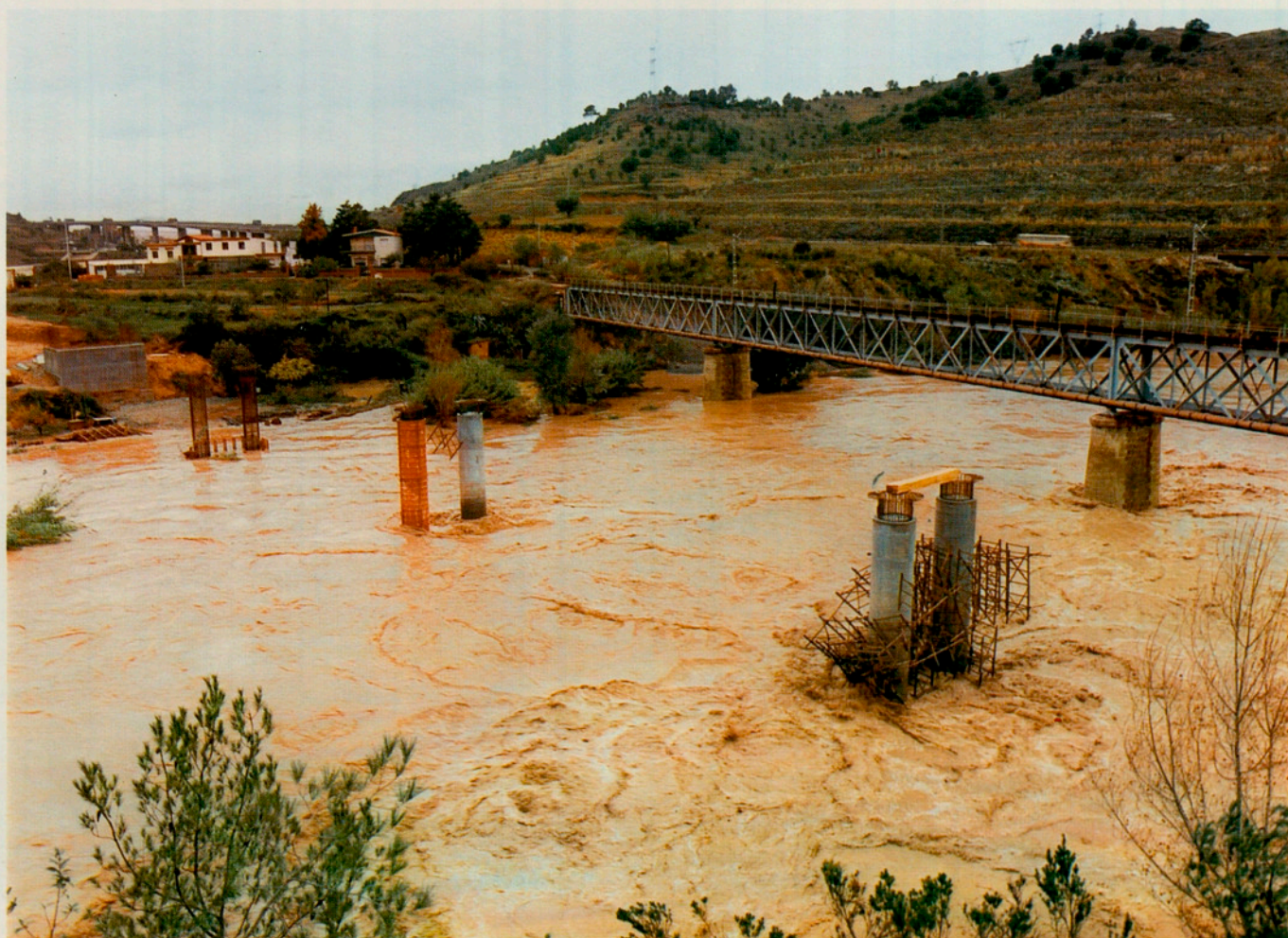
El riu Llobregat, crescut al seu pas sota el pont dels F.G.C., aigües avall de Martorell (El Baix Llobregat).
