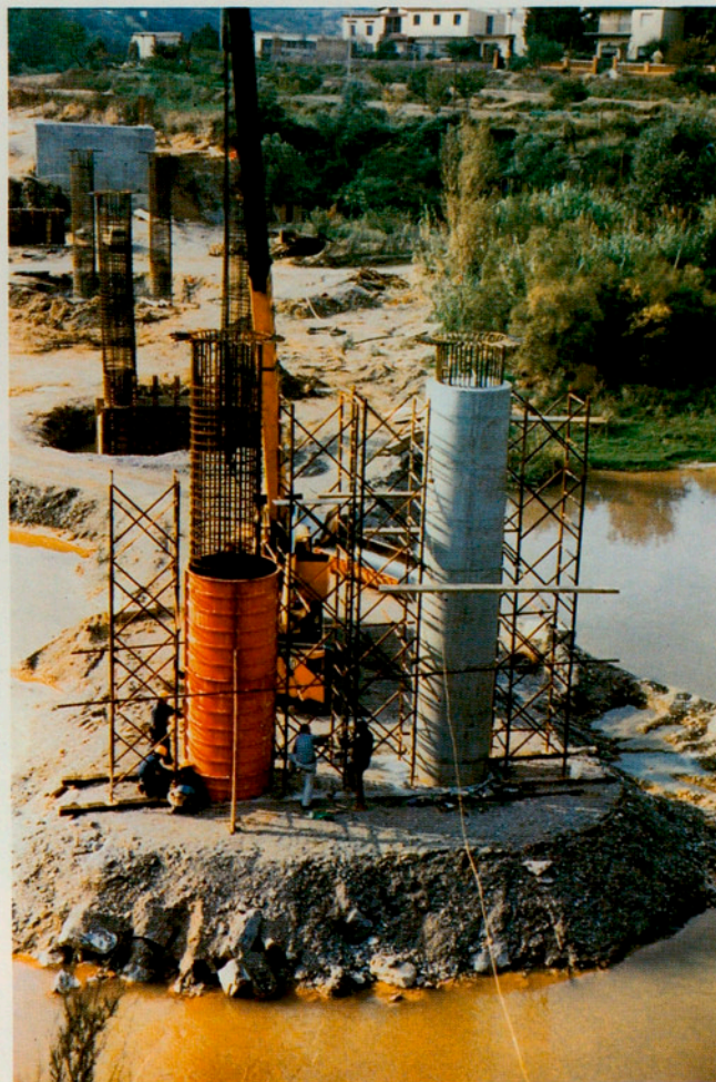
Construcció de les piles del pont dels F.G.C. sobre el riu Llobregat a Martorell (El Baix Llobregat).
