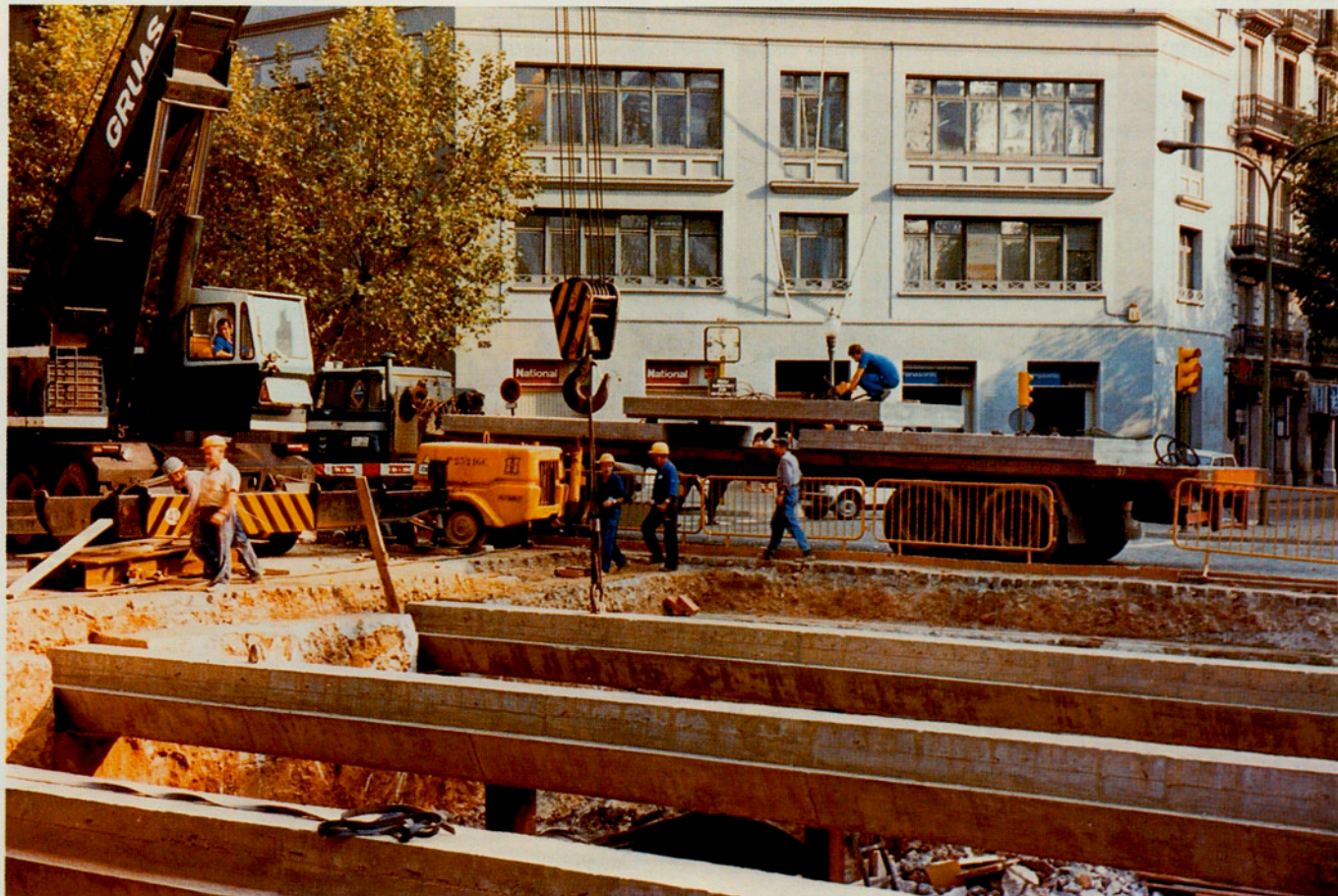
Obres del nou vestíbul de l'estació Urgell a la Línia I F.M.B., (El Barcelonès).
