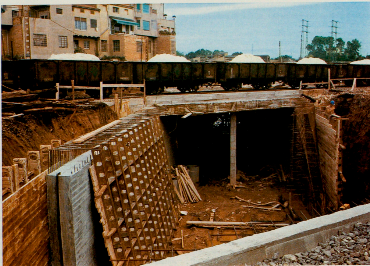
Accés a l'estació d'autobusos de Manresa (El Bagès).
