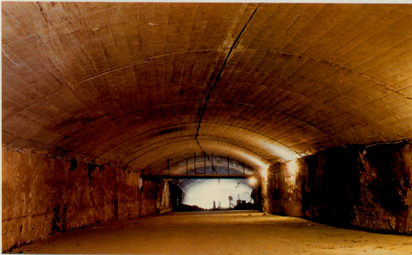
Infraestructura de la Línia I del F.M.B., tram Torres i Bages-Santa Coloma de Gramenet (El Barcelonès).
