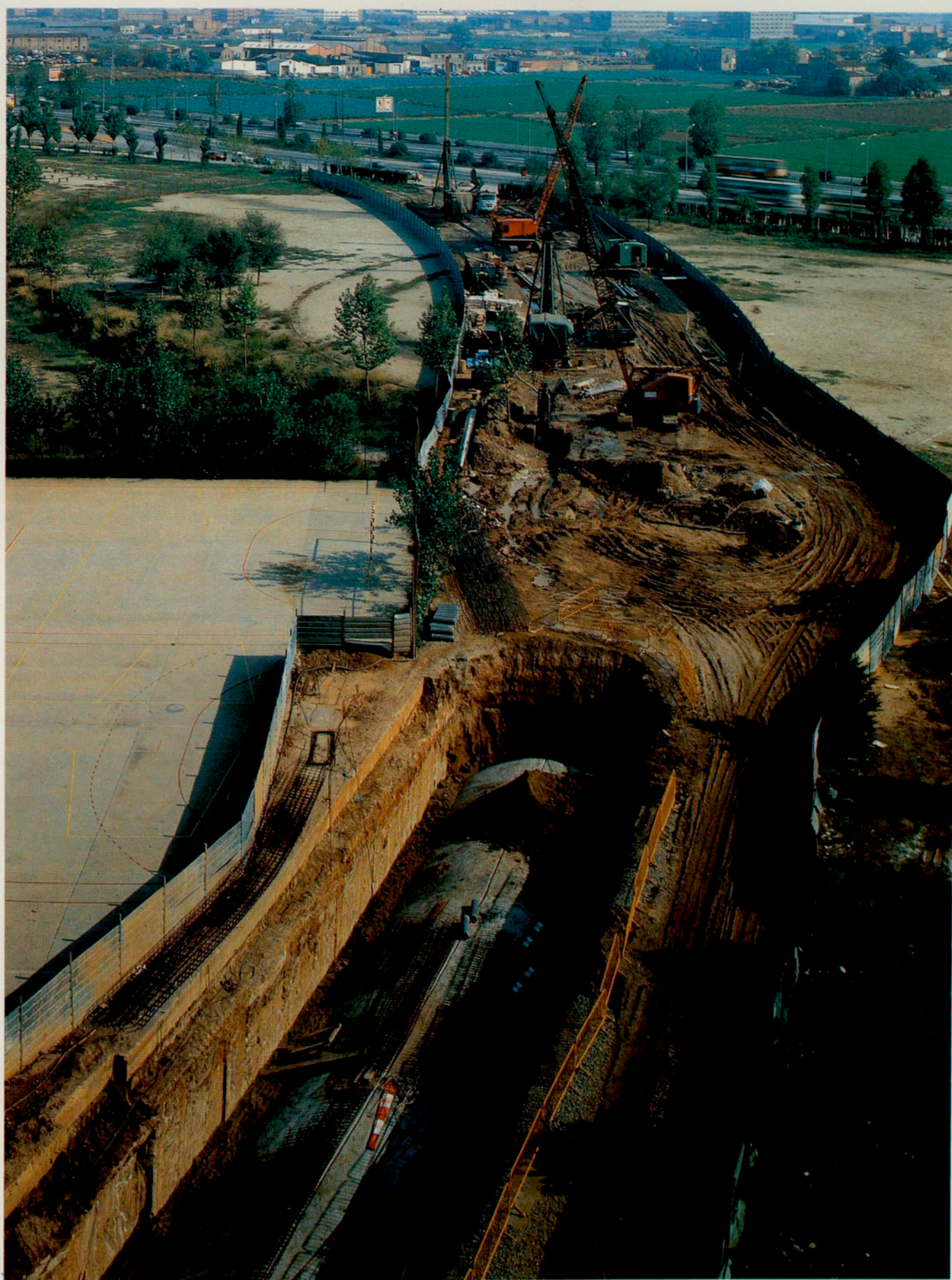
Infraestructura del tram Bellvitge-Plaça Cerdà dels F.G.C. (El Barcelonès).
