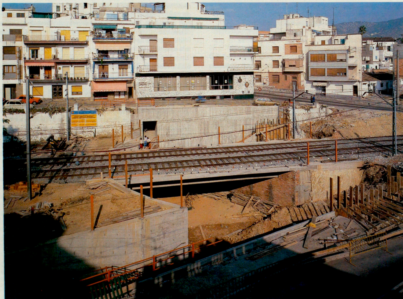
Pas inferior de vianants sota RENFE a l'estació de Sitges (Garraf).
