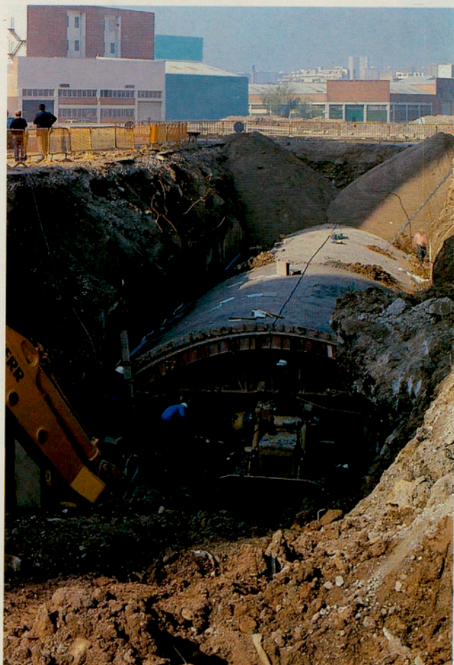
Infraestructura prolongació Línia I a Bellvitge (El Barcelonès).
