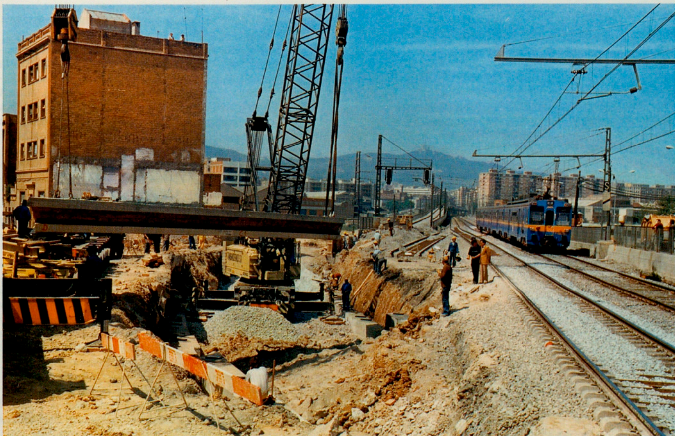
Infraestructura dels F.G.C., tram Sant Josep-Bellvitge al seu pas sota RENFE (El Barcelonès).
