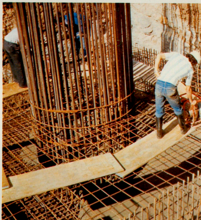
Armadura de fonament i pila.
