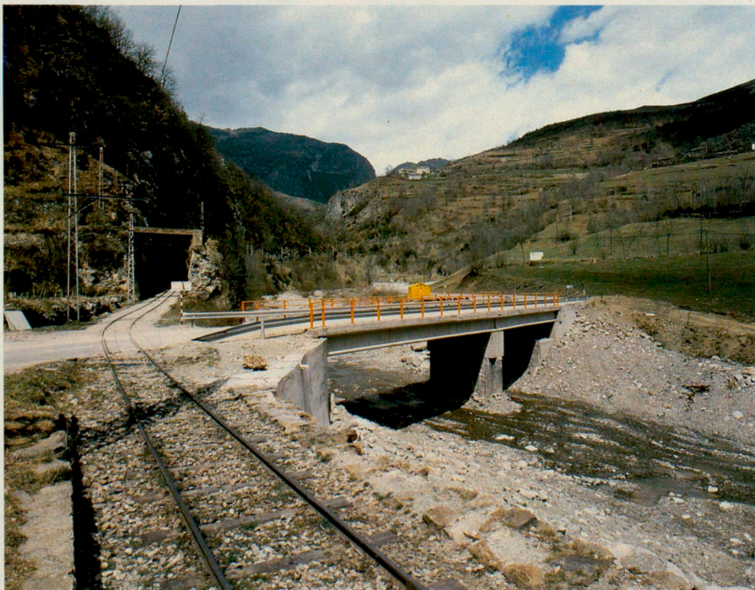
Pont sobre el riu Freser, reconstruït arran de les riuades (El Ripollès).
