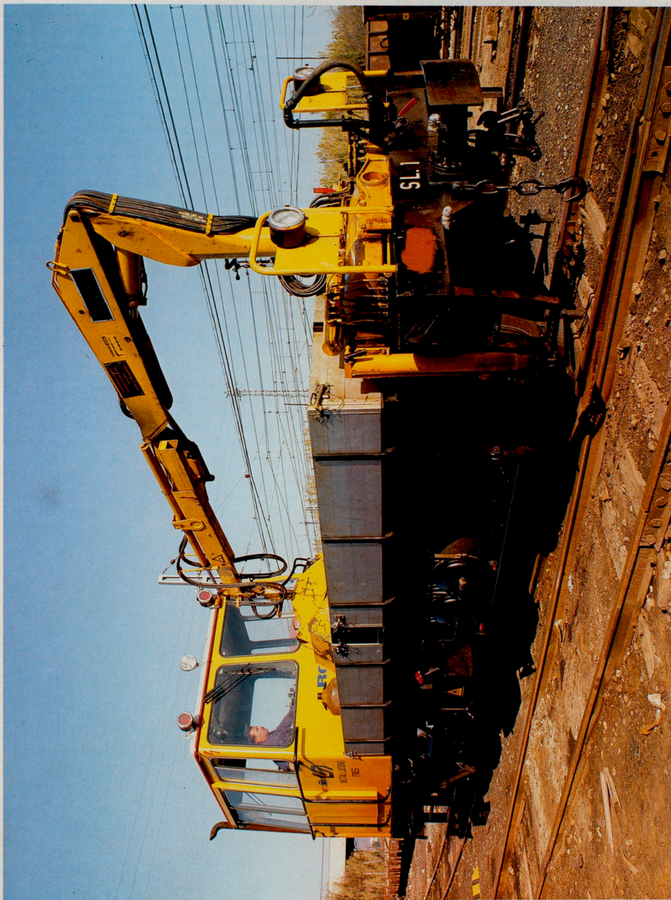
Maquinària per a la renovació de via dels F.G.C.
