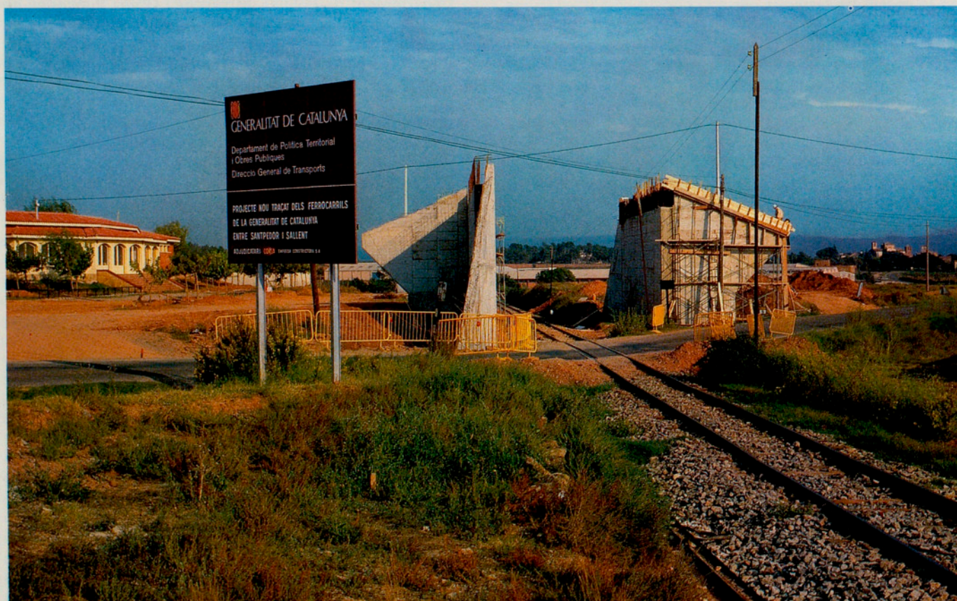
Construcció nou traçat dels F.G.C. entre Santpedor i Sallent (Bagés).
