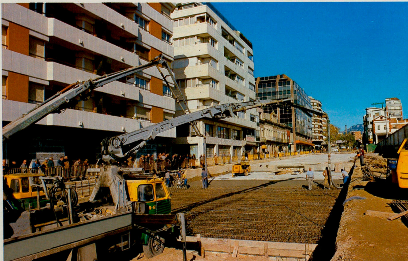
Soterrament de la via dels F.G.C. a Terrassa (Vallès Occidental).
