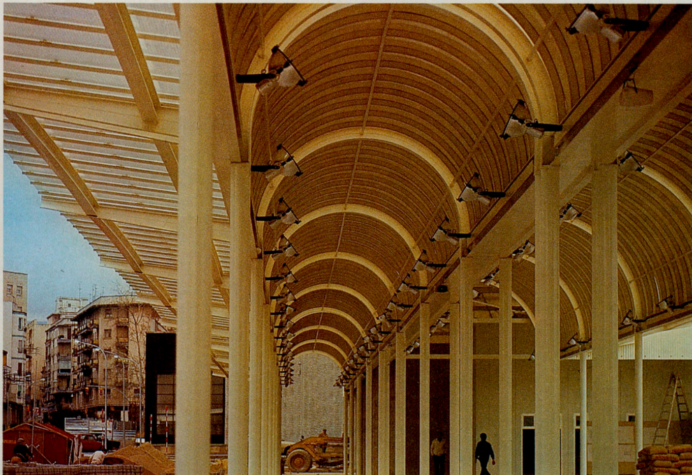
Estació d'autobusos de Reus (Baix Camp).
