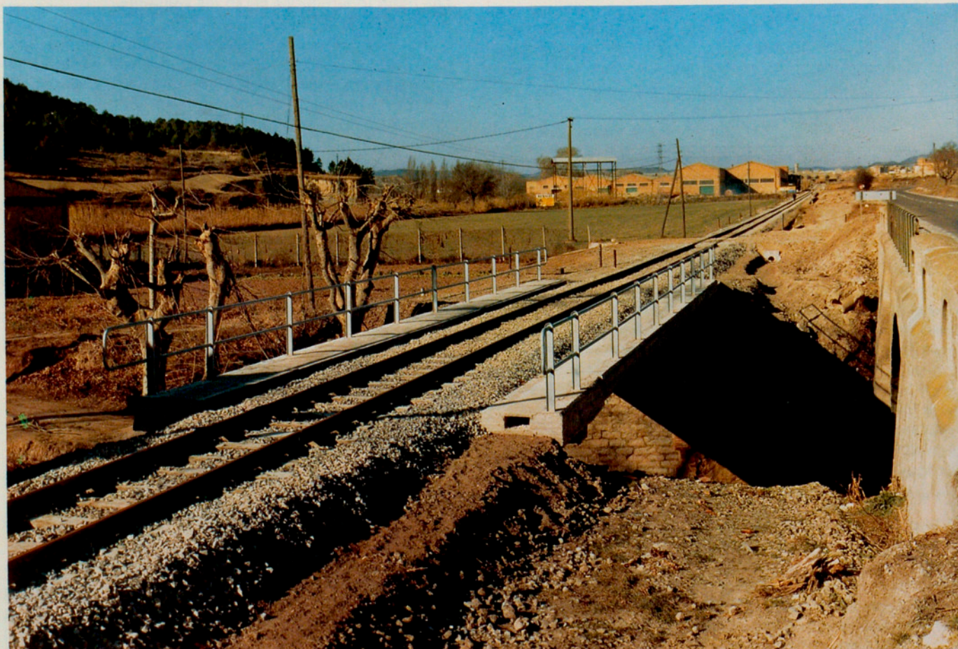
Construcció d'un pont i renovació de via dels F.G.C. al tram La Pobla de Claramunt-Vilanova del Camí (Anoia).
