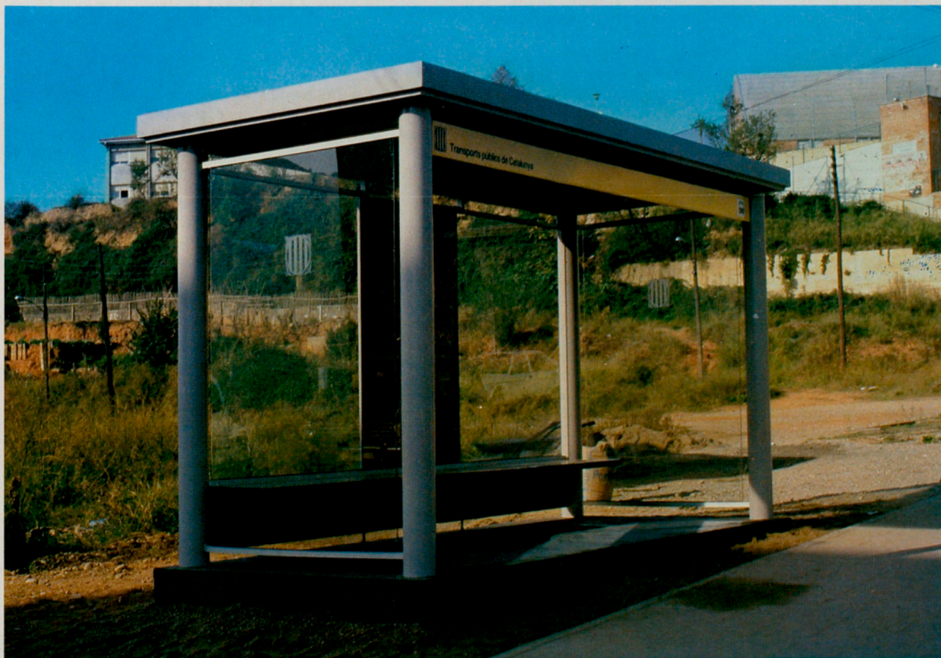
Marquesina d'autobusos interurbans a Martorell (Baix Llobregat).
