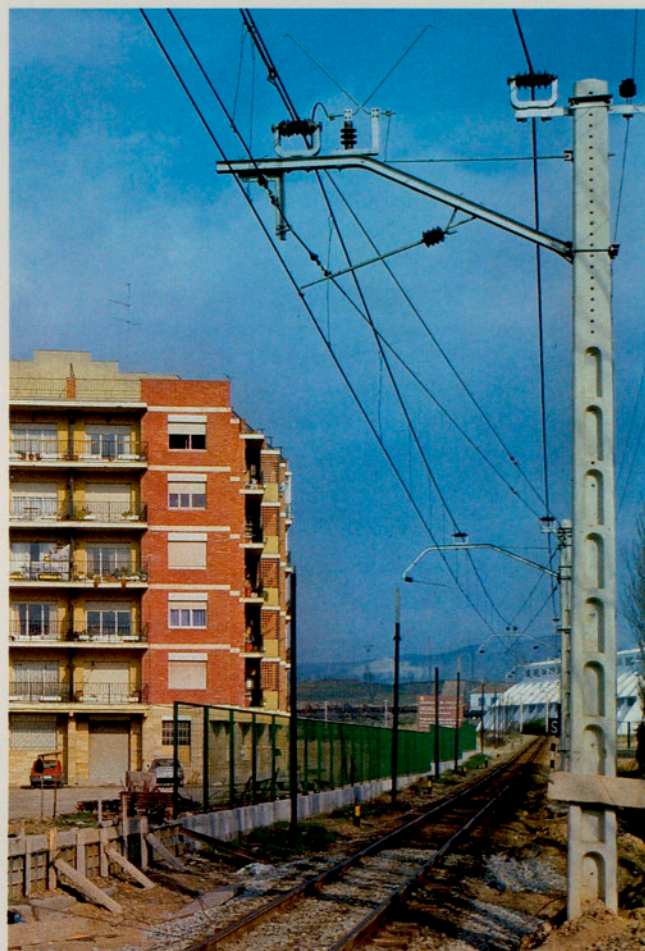
Tancat a l'estació de Sant Vicenç de Castellet dels F.G.C. (Bagés).
