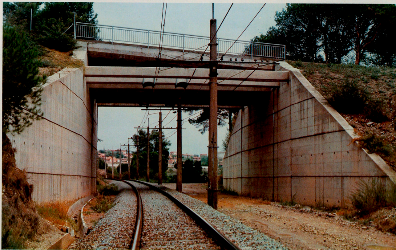
Supressió pas a nivell dels F.G.C. a Bellaterra, Cerdanyola del Vallès (Vallès Occidental).
