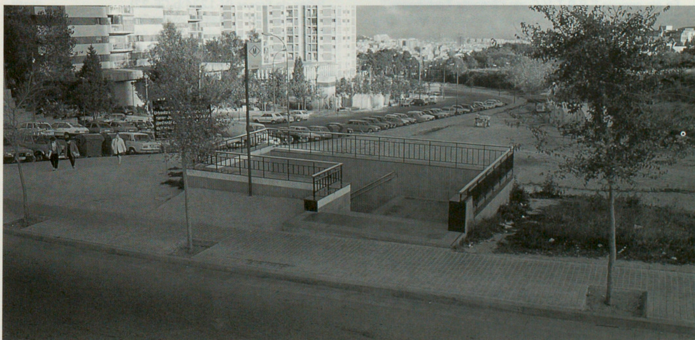
Accés a l'estació «Montbau» de la L.3 del F.M.B. (Barcelonès).
