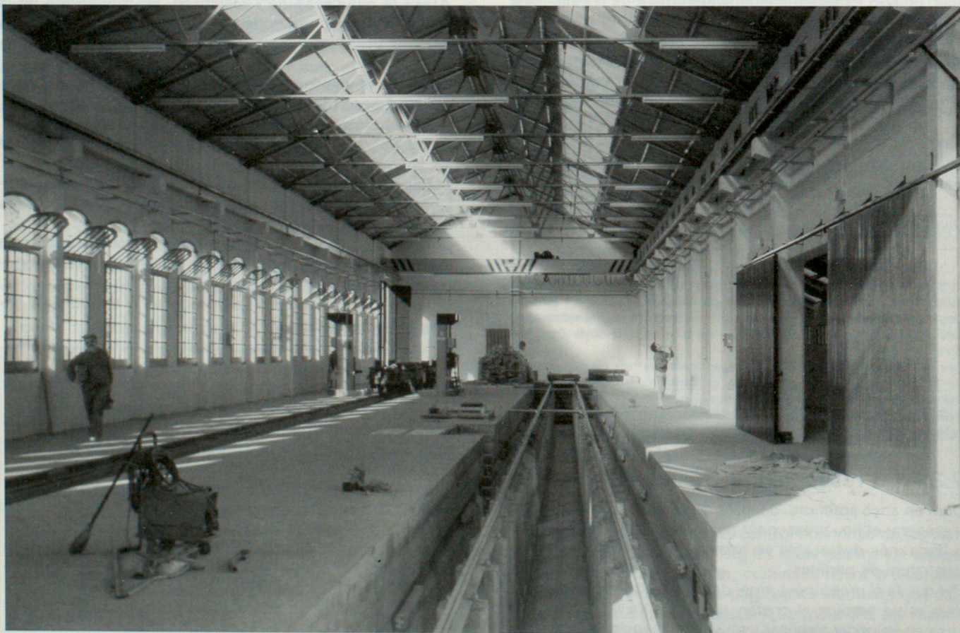
Tallers per al nou material de F.M.G.P. a l'estació de Ribes-Vila (Ripollet).
