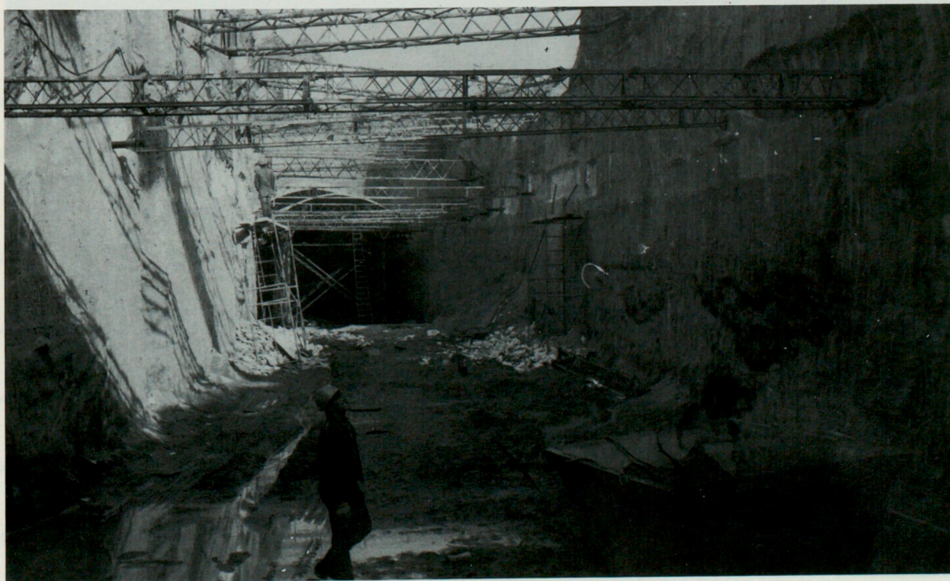
Infraestructura del tram Gornal-Cerdà de la línia de Catalans de FGC. (Barcelonès).
