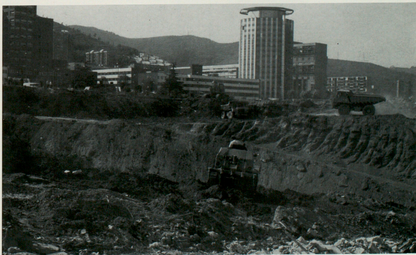
Moviment de terres per a la construcció de les cotxeres de Sant Genís del FMB. (Barcelonès).
