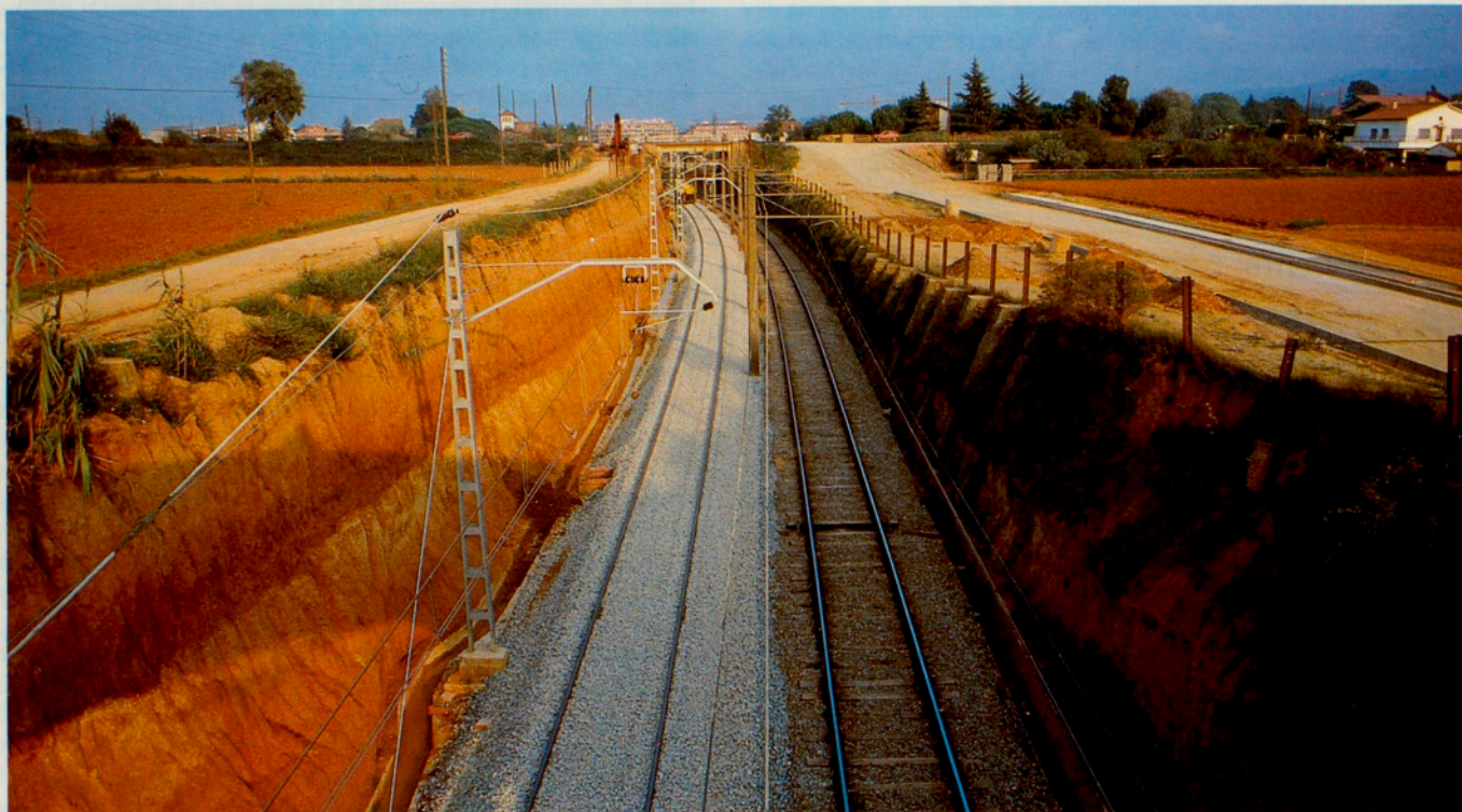
Instal·lació de doble via entre les estacions de Sant Cugat i Rubí de la línia de Catalunya de FGC. (Vallès Occidental).
