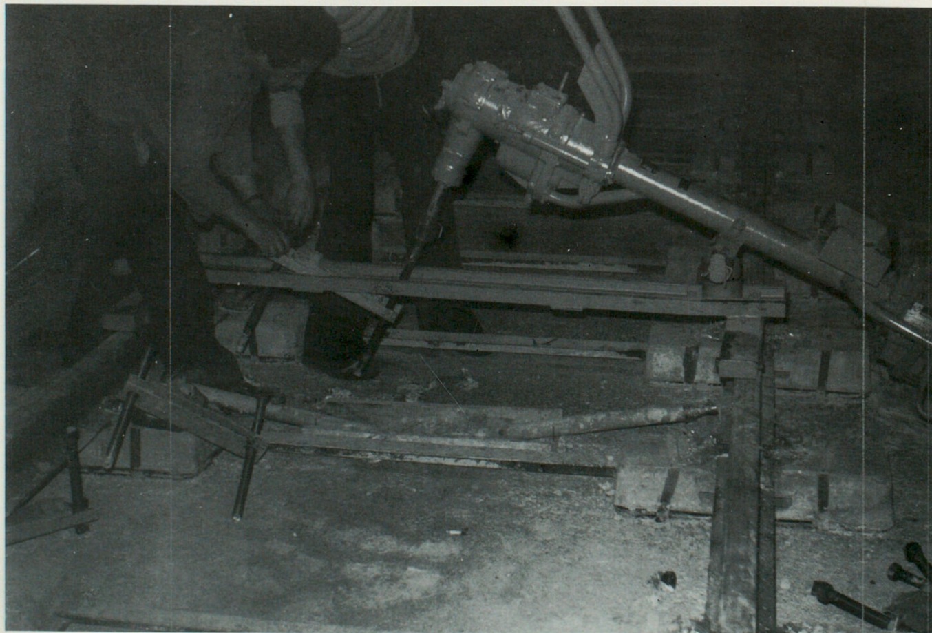
Superestructura del tram «Torrassa» - «Av. Carrilet» de la L1 del FMB. (Barcelonès).
