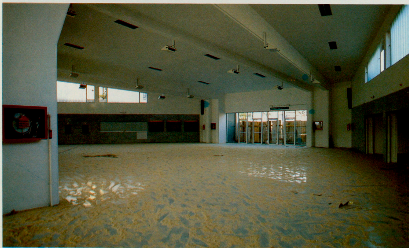
Vestíbul de l'estació d'autobusos de Tarragona (Tarragonès).
