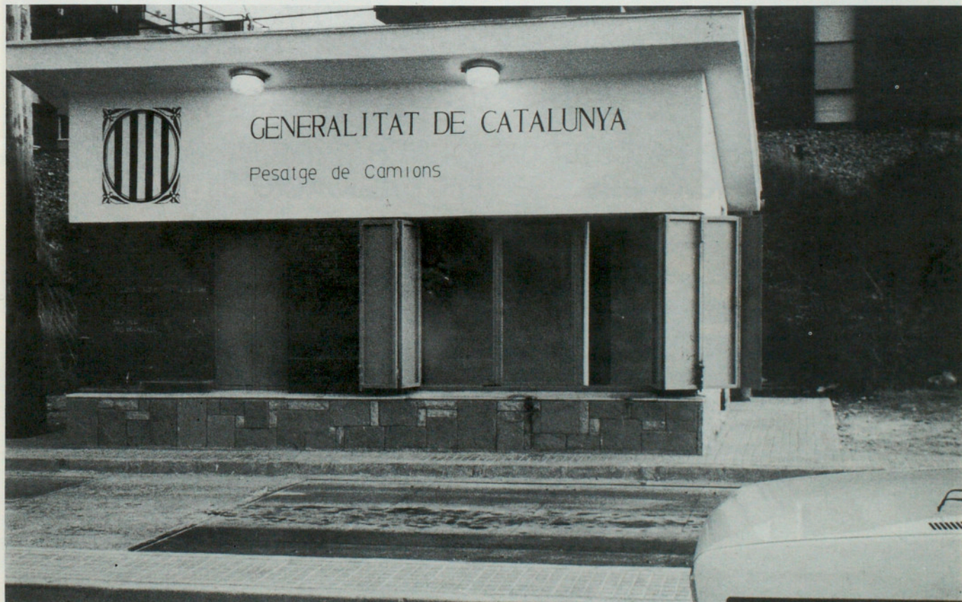
Bàscula de pesatge de camions a Castelldefels (Baix Llobregat).
