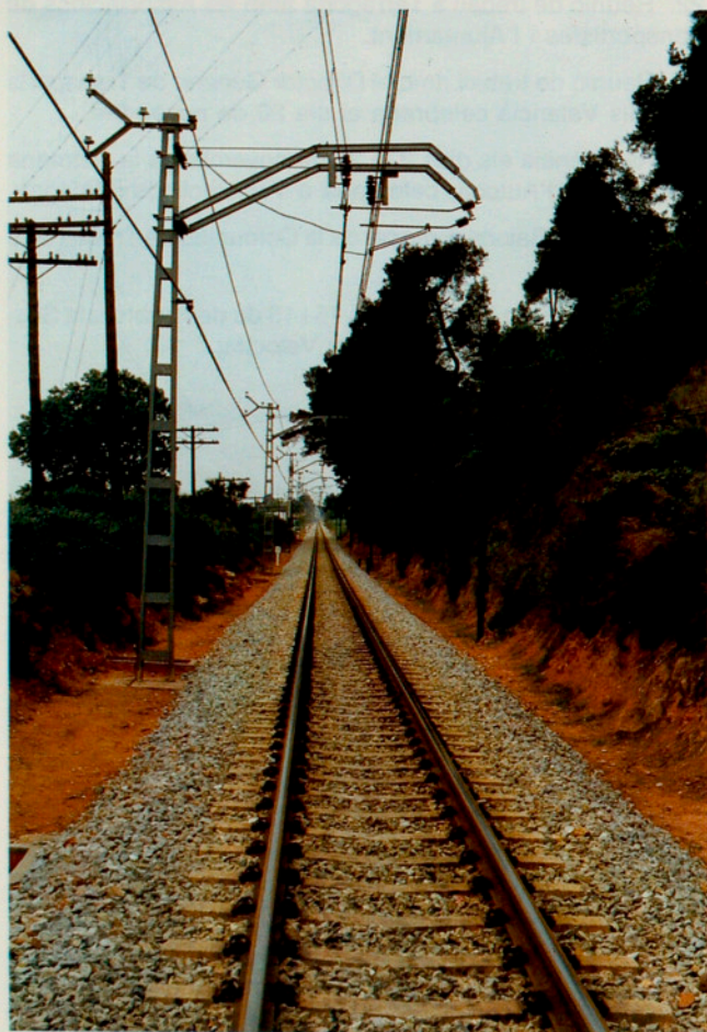
Renovació de via i electrificació del tram Pallejà-Martorell de la línia de Catalans de F.G.C. (Baix Llobregat).
