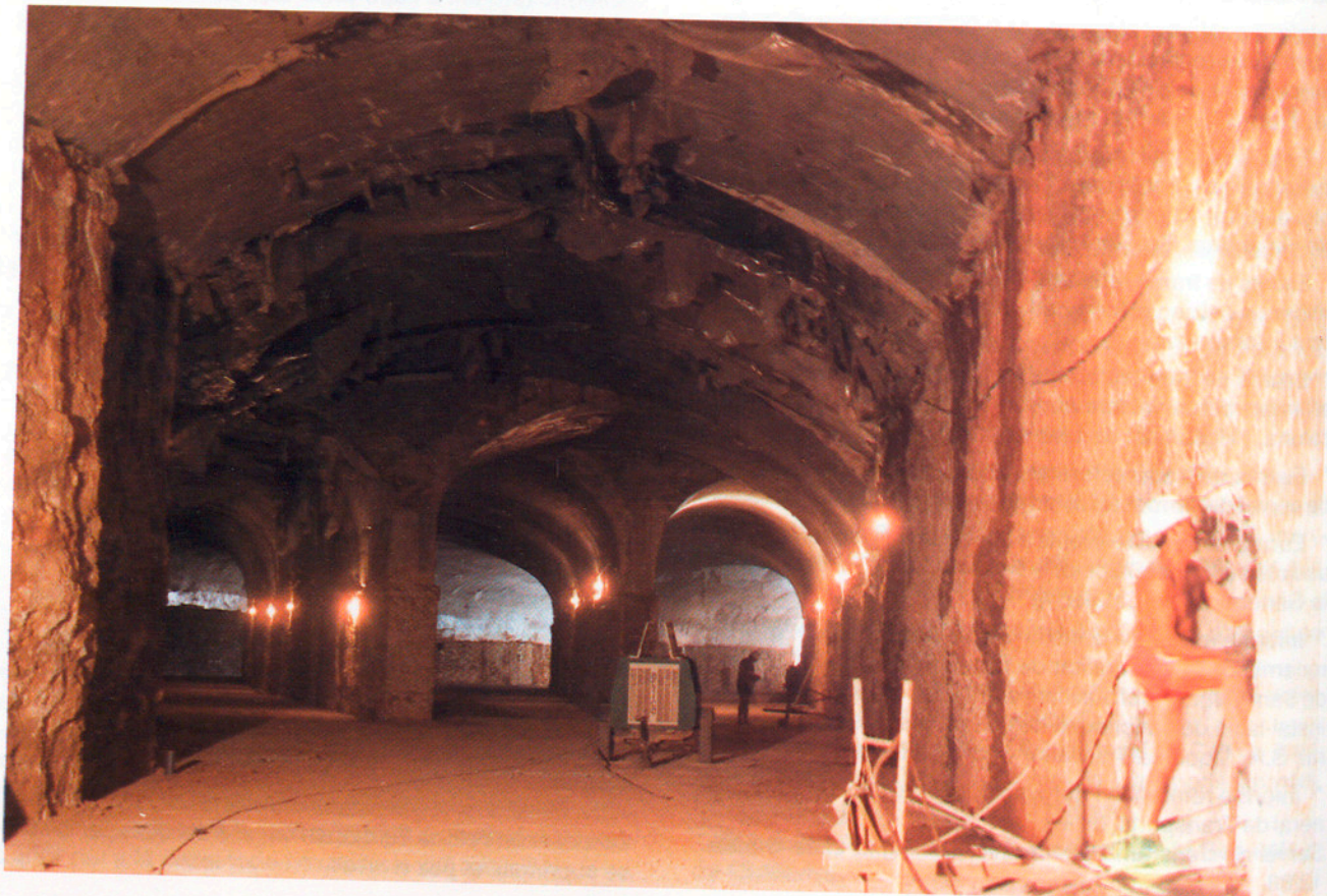
Túnel d'accés a les cotxeres de Sant Genís de la L3 de l'FMB (Barcelonès).
