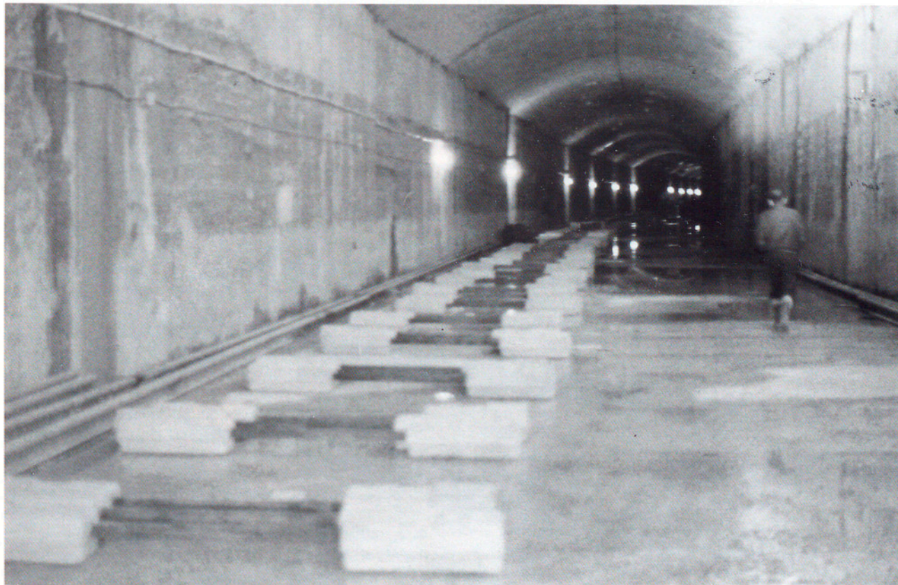
Instal·lació de vies i carril conductor al tram Av. Carrilet-Feixa Llarga de la L1 de l'FMB a l'Hospitalet de Llobregat (Barcelonès).
