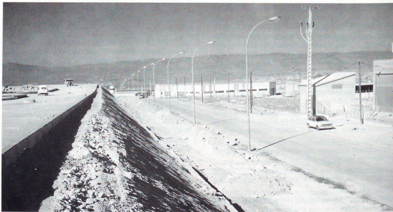
Obres de l'aparcament i de la infraestructura bàsica de la central integrada de mercaderies a Manresa (Bages).
