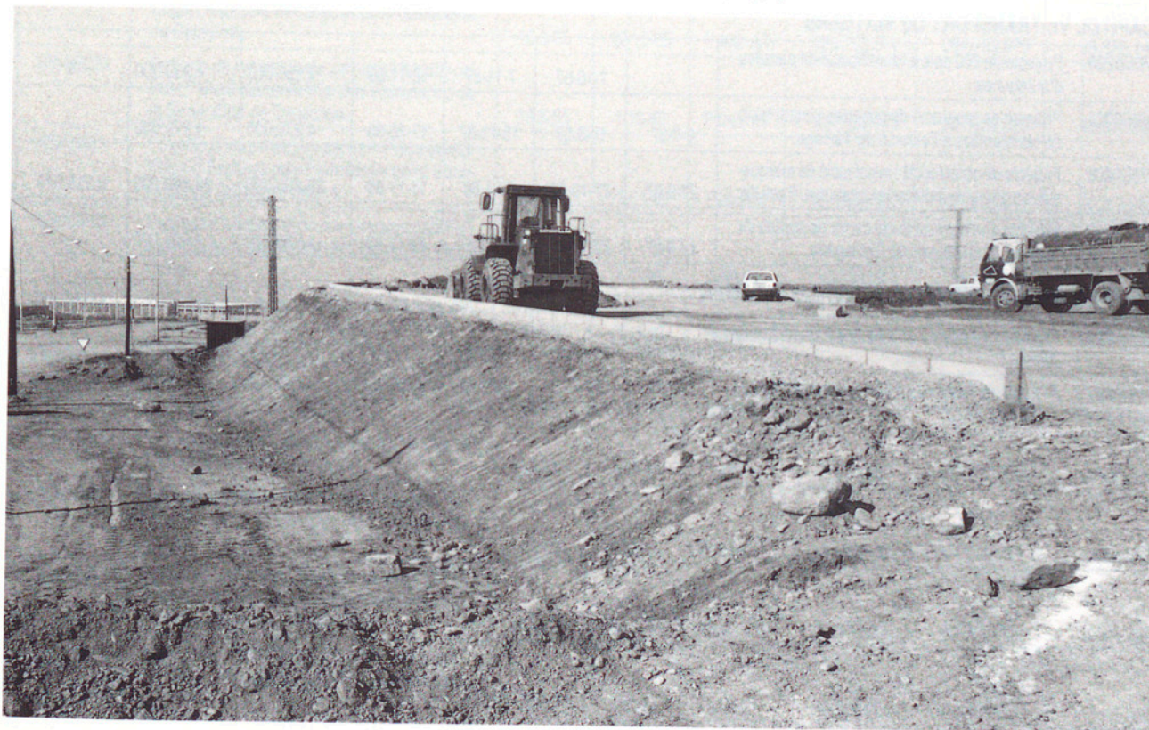
Obres d'esplanació dels vials de la central integrada de mercaderies de Manresa (Bages).
