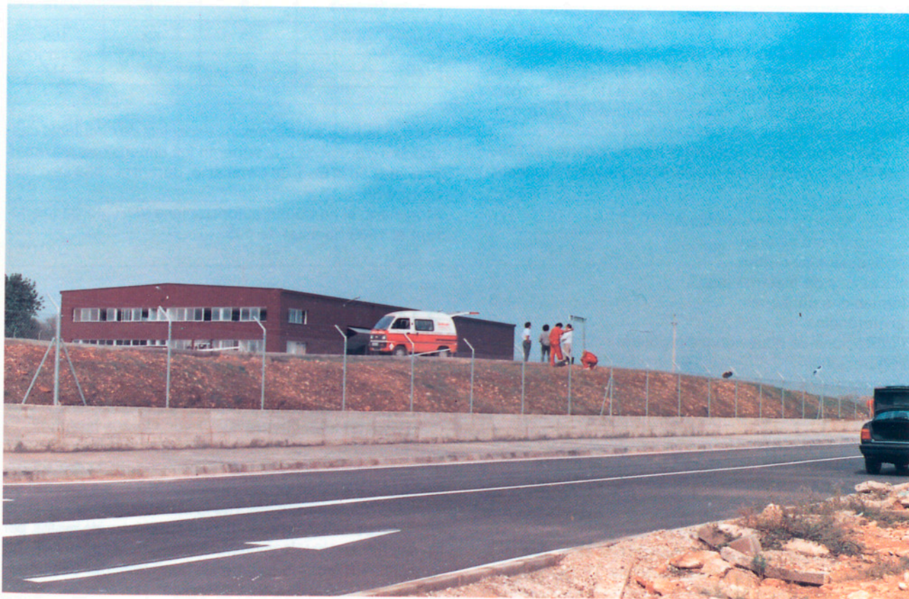
Nau-taller de l'aparcament per a vehicles pesants a Amposta (Montsià).
