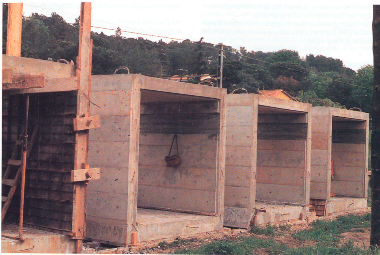
Caixons de formigó armat prefabricats del pas inferior de vianants a Gualba (Vallès Oriental).
