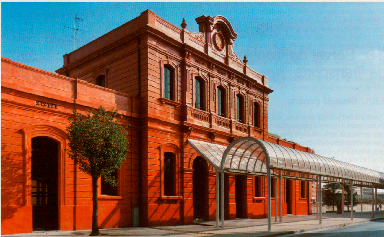
Estació d'autobusos a Sabadell. Rehabilitació d'una estació de Renfe (Vallès Occidental).
