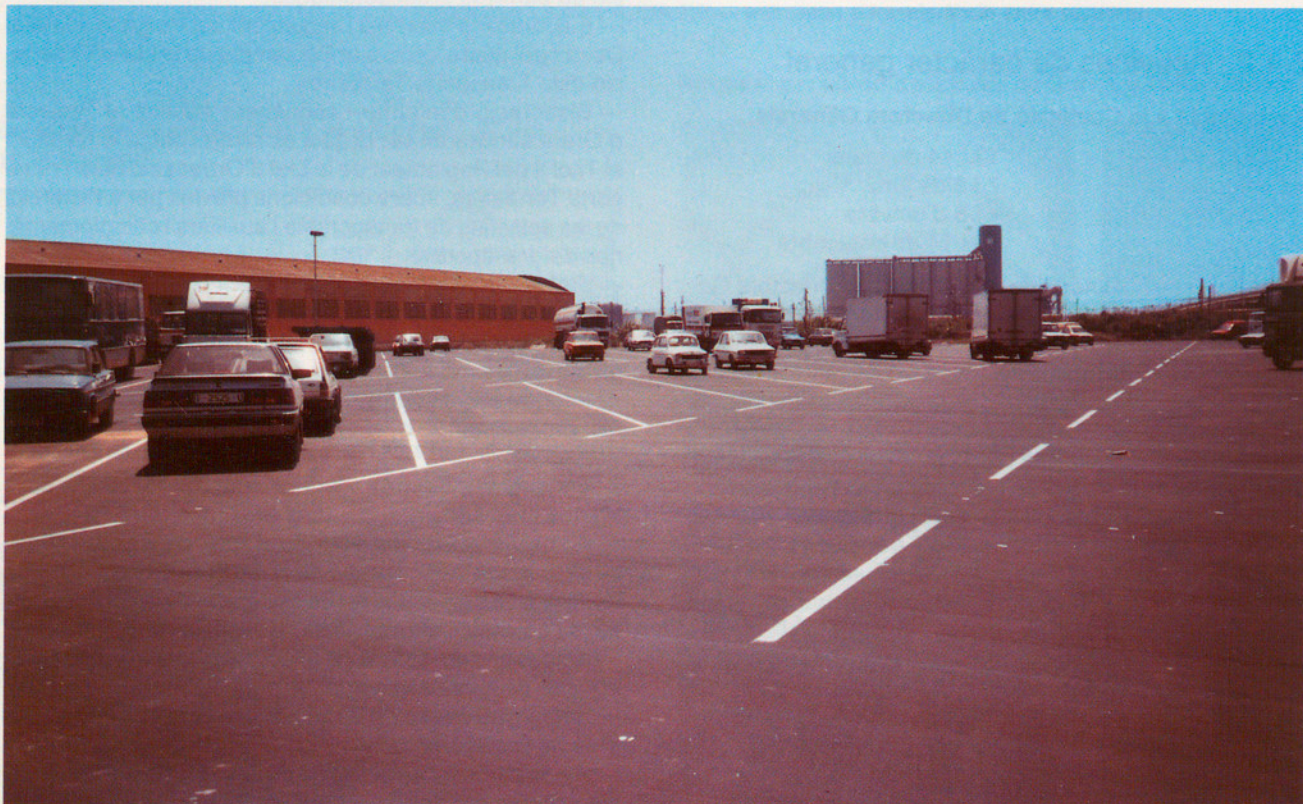
Pavimentació de l'aparcament del polígon industrial del Francolí a Tarragona (Tarragonès).
