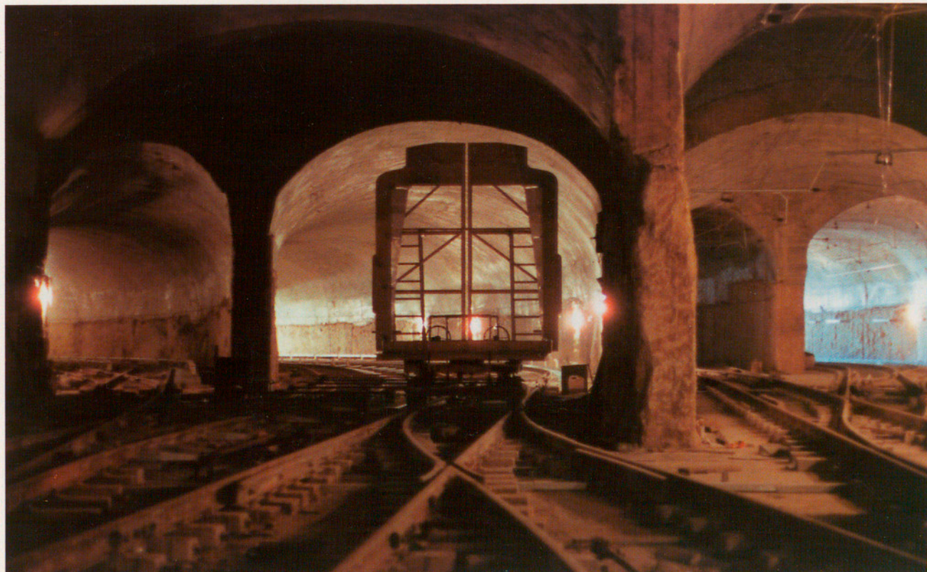
Superestructura de les cotxeres i tallers de St. Genís de la L3 del Metro de Barcelona (Barcelonès).
