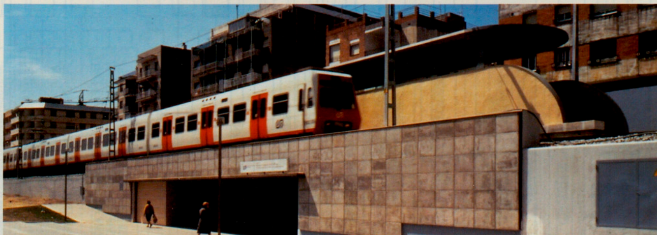
Condicionament del baixador de Can Ros a la línia de Catalans dels FGC. (Baix Llobregat).
