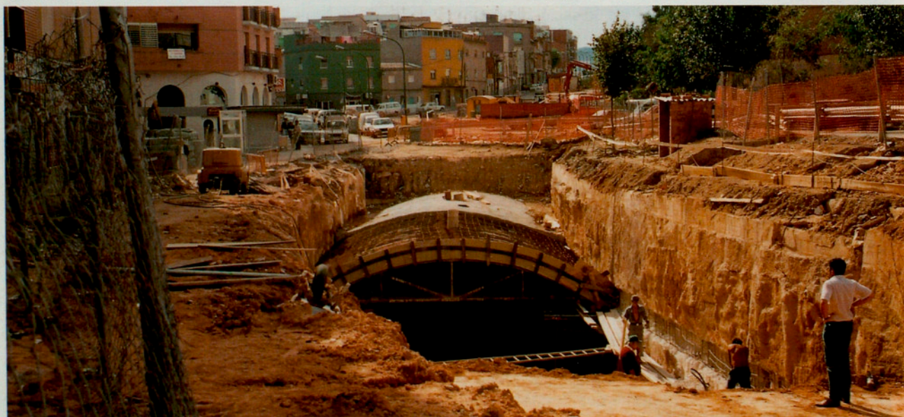
Construcció del túnel de la cua de maniobres de l'estació de Fondo de l'L1 de l'FMB. (Barcelonès).
