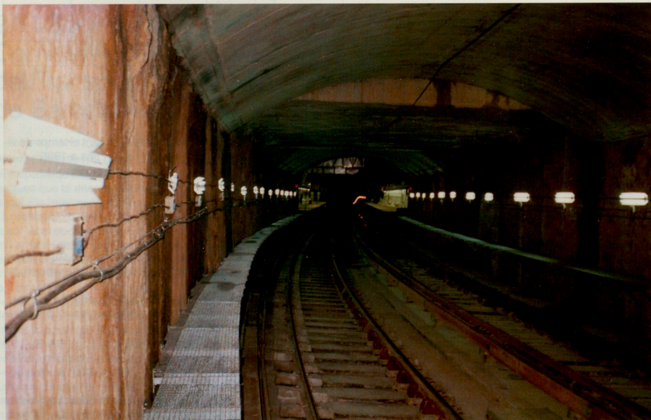
Superestructura de la cua de maniobres de l'estació de Fondo de l'L1 de l'FMB. (Barcelonès).
