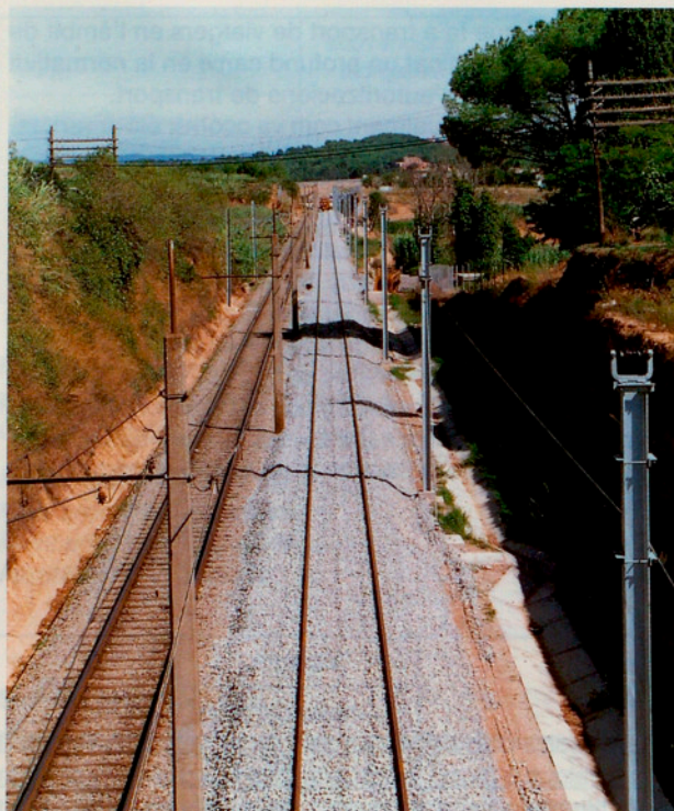
Construcció de via doble entre Rubí i Terrassa a la línia de Catalunya dels FGC. (Valles Occidental).
