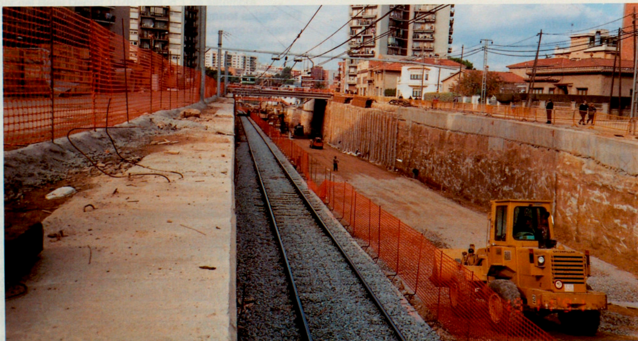
Semisoterrament de l'estació de Rubí a la línia de Catalunya dels FGC. (Vallès Occidental).
