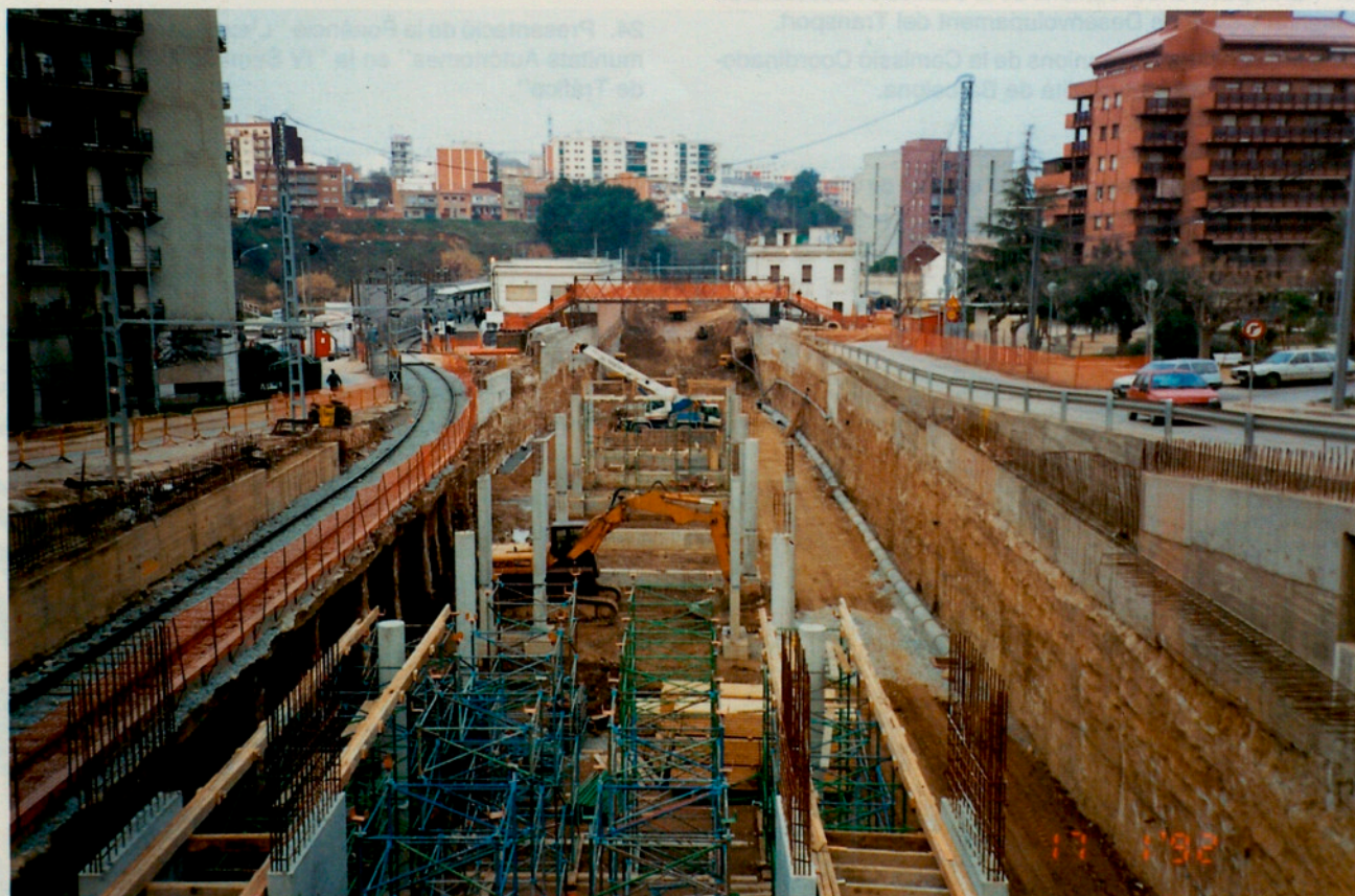
Semisoterrament de l'estació de Rubí a la línia de Catalunya dels FGC. (Vallès Occidental).
