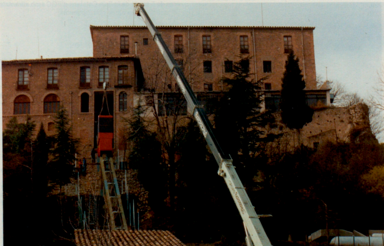
Ascensor inclinat al Santuari de Queralt. (Berguedà).
