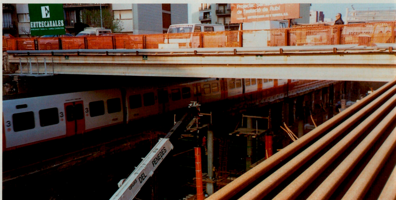
Semisoterrament de l'estació de Rubí a la línia de Catalunya dels FGC. (Vallès Occidental).
